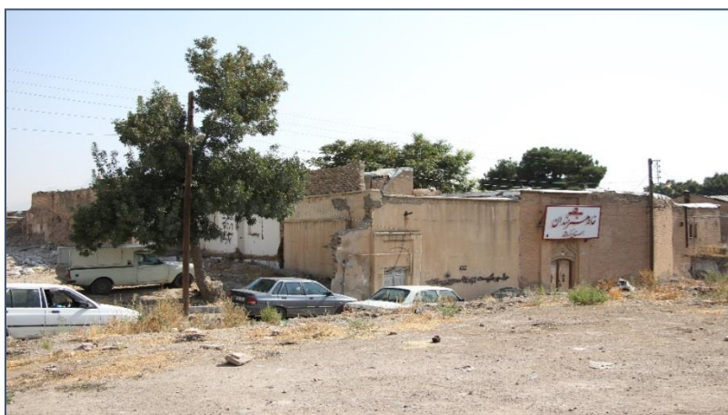
شکل ۲. بافت تاریخی در حال زوال در مرکز فیض‌آباد
